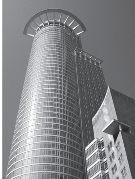
Der auskragende obere Abschluss, der wie eine Krone wirkt, ragt 11 Meter über das Gebäude hinaus und wird im Winter wegen Eisbruchgefahr sogar beheizt. Blickfang vor dem Gebäude ist die 12 Meter hohe Skulptur „Inverted Collar and Tie“ von Claes Oldenburg und Coosje van Bruggen, eine umgedrehte in die Luft gehende Krawatte.
