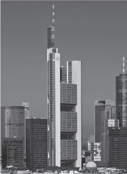
Das höchste Bürogebäude Europas. Die Rahmenkonstruktion ist weltweit einmalig. Sie überspannt die integrierten Turmgärten stützenfrei. Diese „grünen Lungen“ des Hauses bieten jeweils eine andere Vegetation (mediterran, asiatisch etc.) und sind Teil eines besonderen Lüftungssystems.
